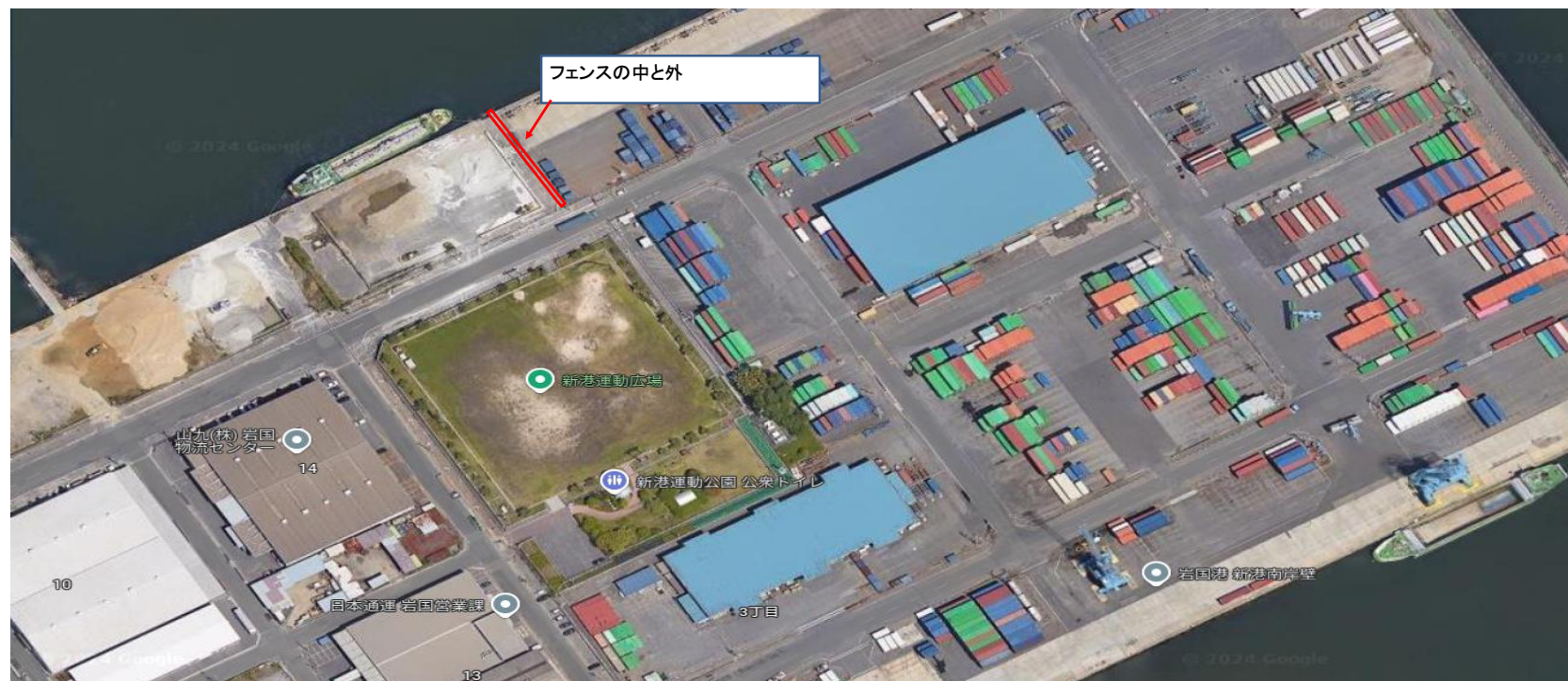
新港町ゲート周辺(ソーラスフェンス内)
