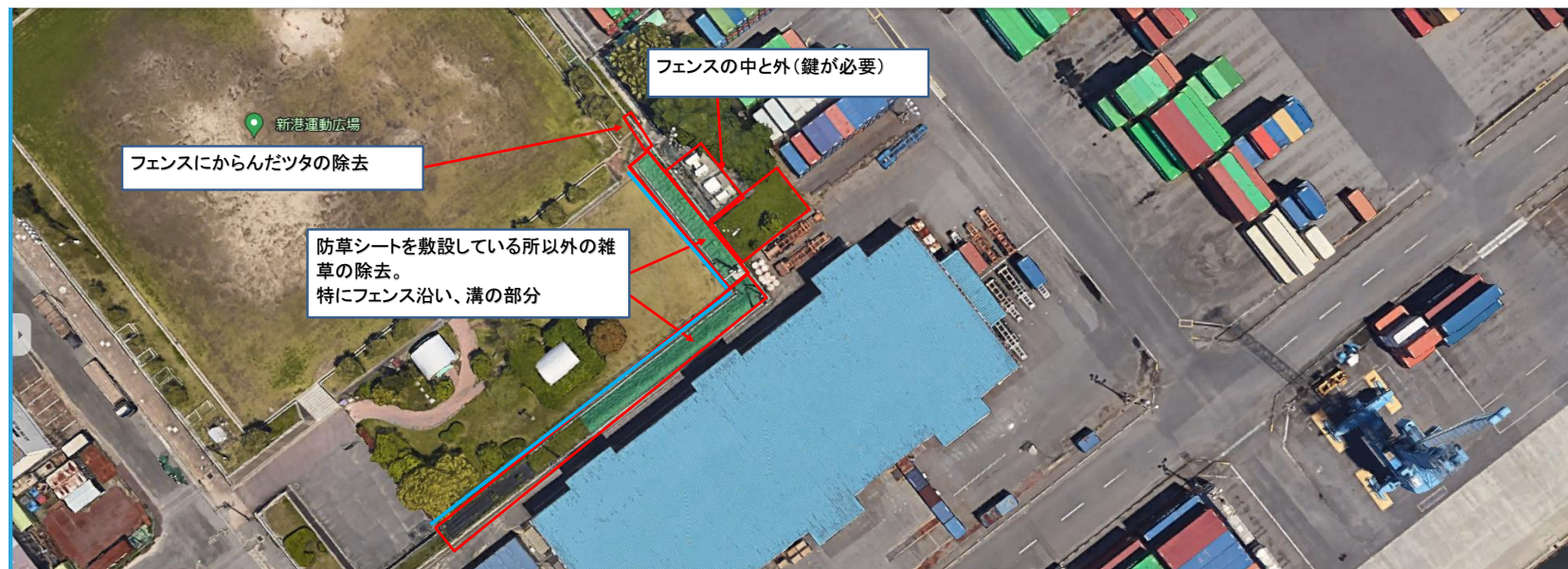
新港町運動公園周辺(ソーラスフェンス内)
