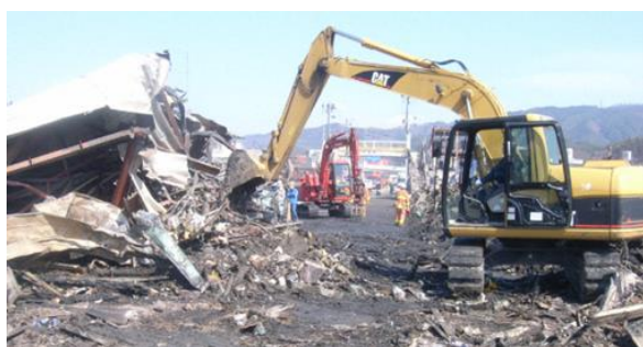
バックホウによる啓開作業
