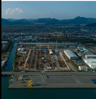
防府工場全景
