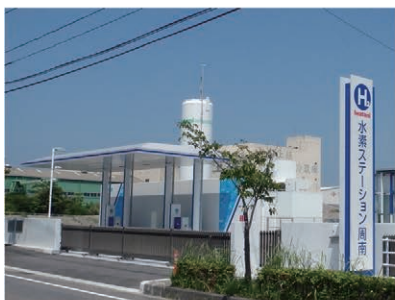
水素ステーションの整備
