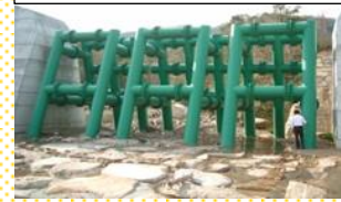
流木捕捉式治山ダム
