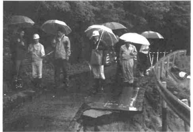
◎県道柳井上関線被災箇所視察(令和5年7月10日)
