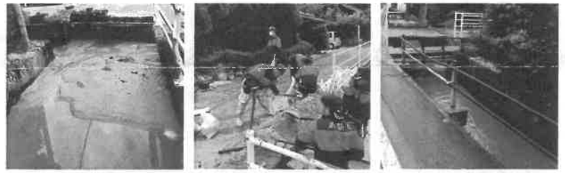
6月30日～7月1日の警報級の豪雨で天神山から土砂が水路沿いに迫戸川に流出。橋桁に迫る勢いの為、地元消防団の有志と人力で撤去作業。その後重機など市から投入して頂きいつもの流れに戻りました。私、松浦多紋はどこにいるのでしょうか？
