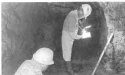
紫福・堀越地区の用水路工事
