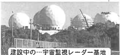
建設中の…宇宙監視レーダー基地
