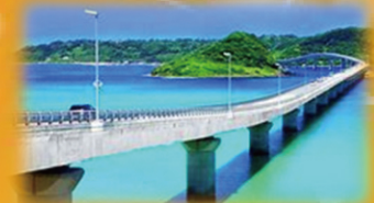
角島大橋 (下関市)
