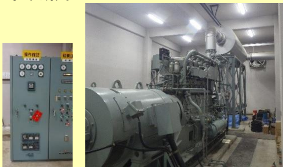
(写真: 厚東川第2期工業用水道発電機更新事業)
