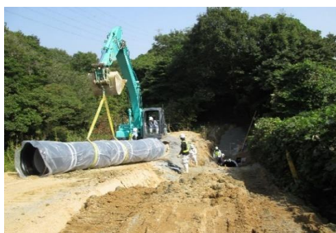
厚東川2期ルートバイパス管布設工事
