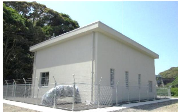
送水ポンプ建屋
