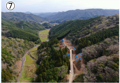
⑦ 6号橋付近
