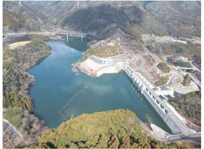
●試験湛水中の状況
