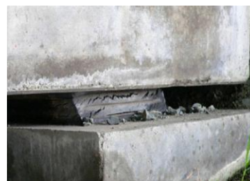
ゴム支承のせん断変形*3
