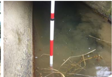
洗掘深さの計測状況
