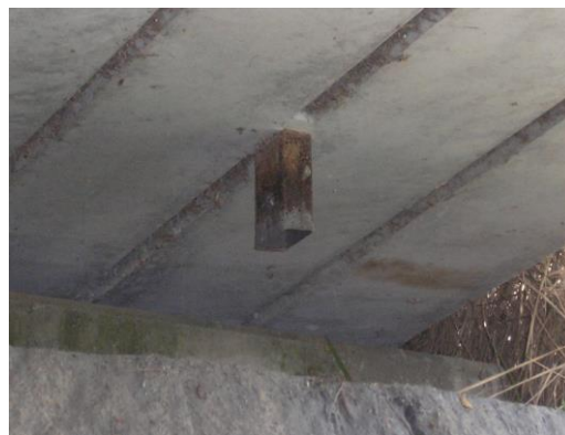
排水管の腐食
