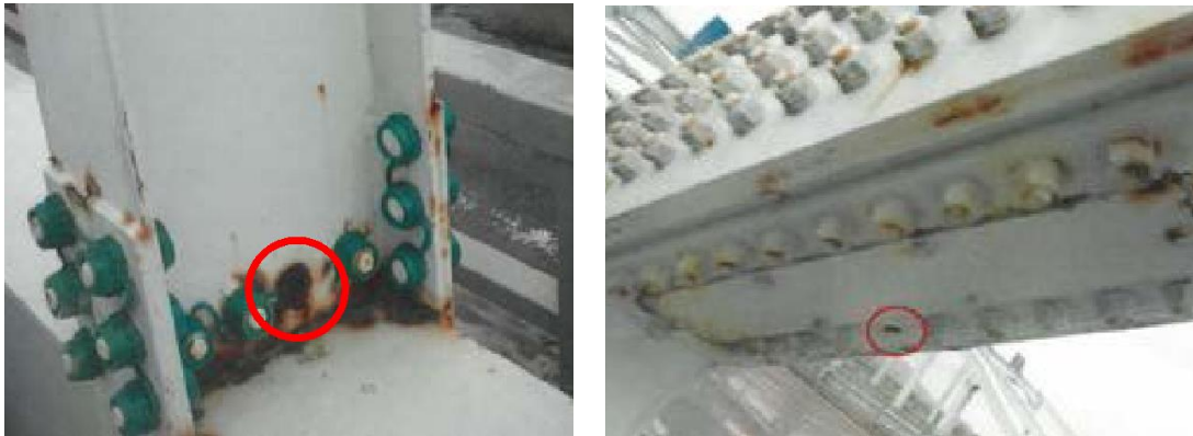
図 3.15 HT ボルトの抜け落ち
