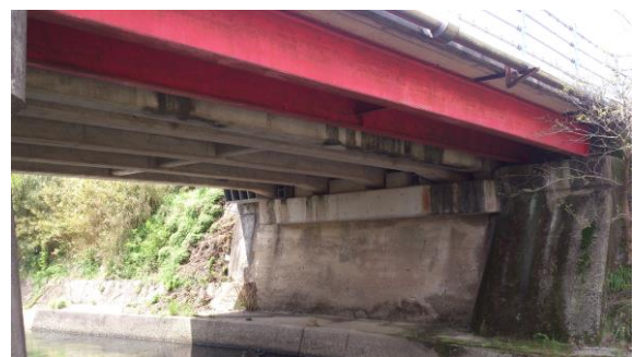
《断面上で鋼桁とコンクリート桁が混在する橋梁》
