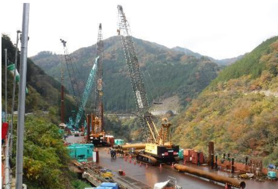
地すべり対策工事 令和2年11月16日（月）撮影 ※1
