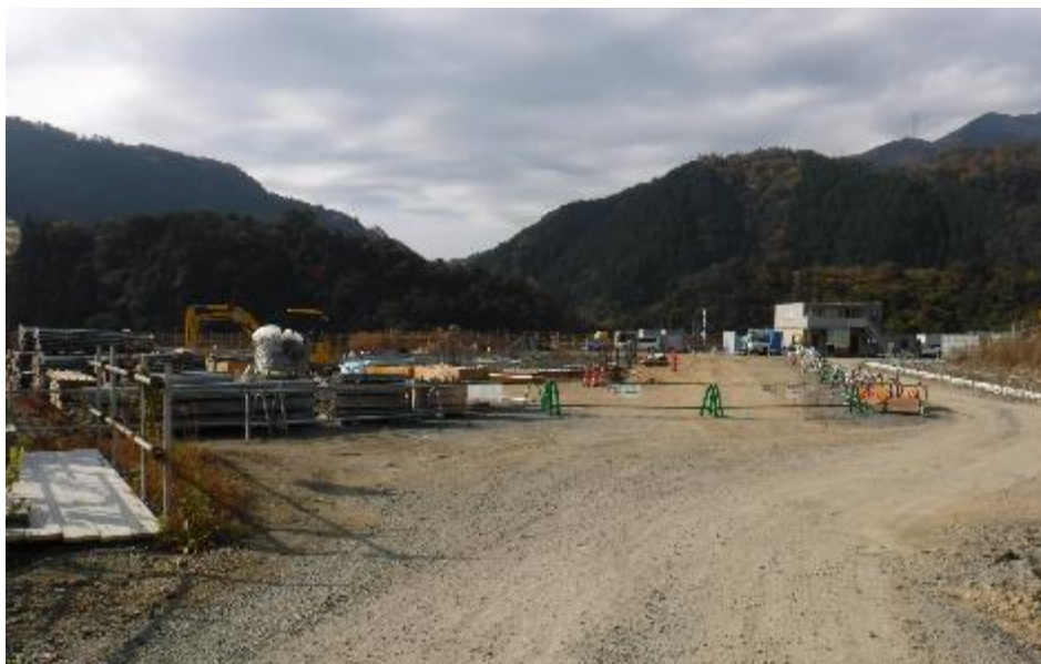
管理事務所棟の建設 令和2年11月16日（月）撮影 ※1
