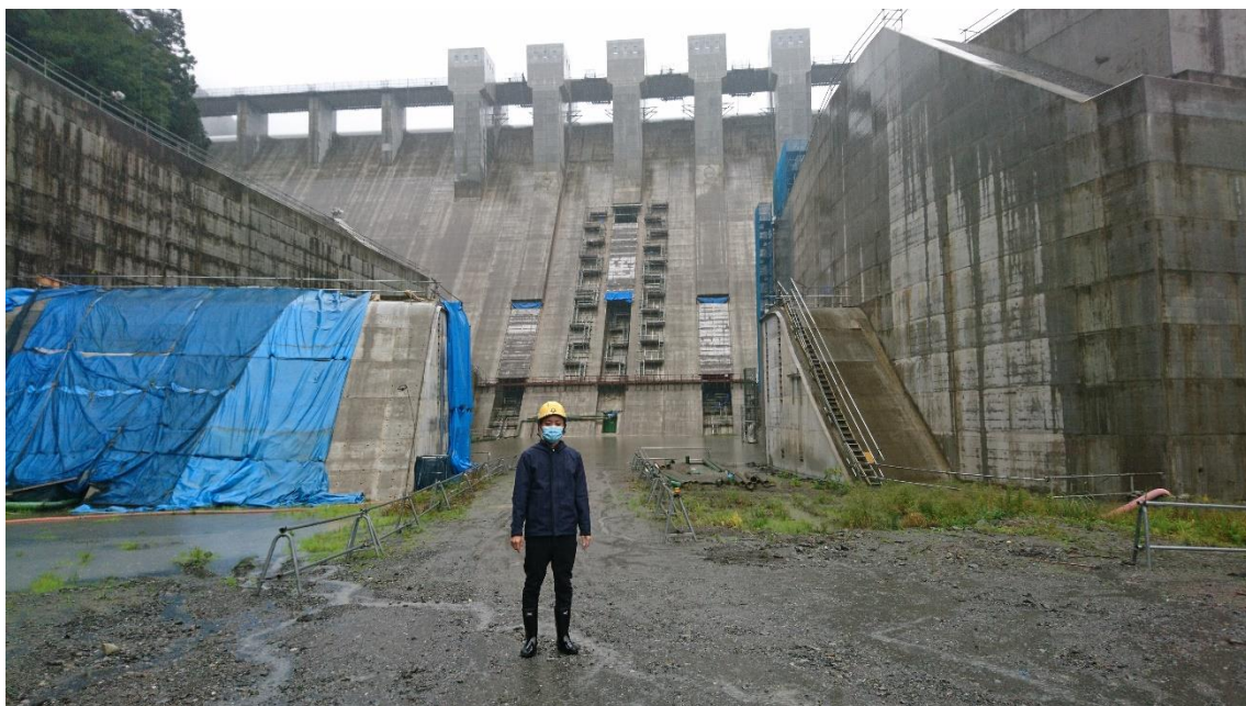
ダム本体堰堤（下流域側） 令和2年10月22日（木）撮影
