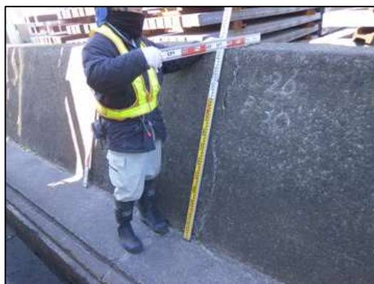
健全度 C (防護機能に影響が無い)
