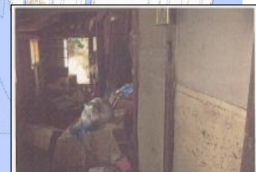
平成14年9月 浸水被害状況
