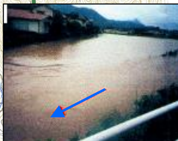
平成11年6月豪雨 浸水状況
