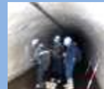
作業員による調査
