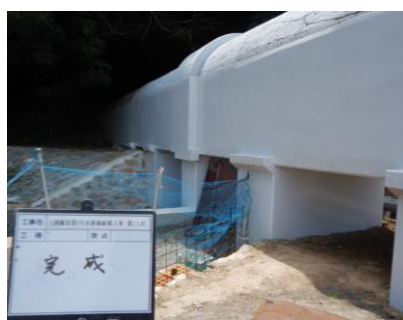
水路橋の耐震対策状況 [木屋川工業用水道]
