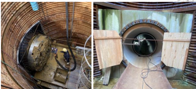
推進工施工中の状況(φ2000HP)
