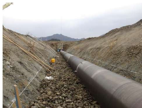
巻線形スクリーン管布設 [佐波川工業用水道]
