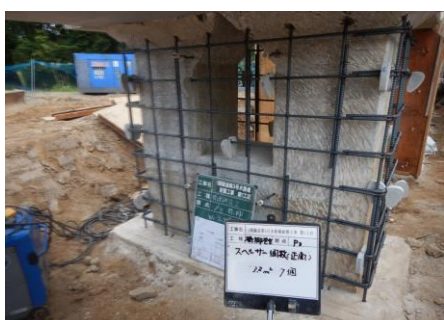
水路橋の耐震対策状況 [木屋川工業用水道]
