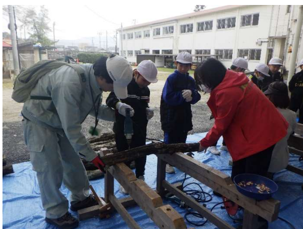
電動ドリルでの穴あけ
