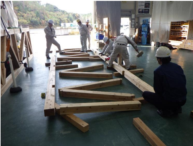
写真1 試験体施工状況（西部）
