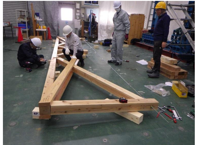
写真2 試験体施工状況（中部）
