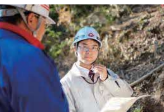
治山工事の施工状況について、現場確認をしています。
