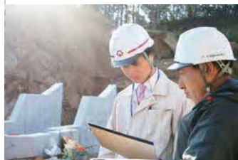
工事の進捗状況等について、工事業者と現場で確認します。
