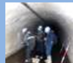
作業員による調査
