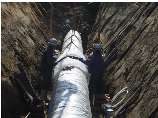
新管布設 [厚東川第2期工業用水道]
