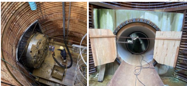
推進工施工中の状況(φ2000HP)
