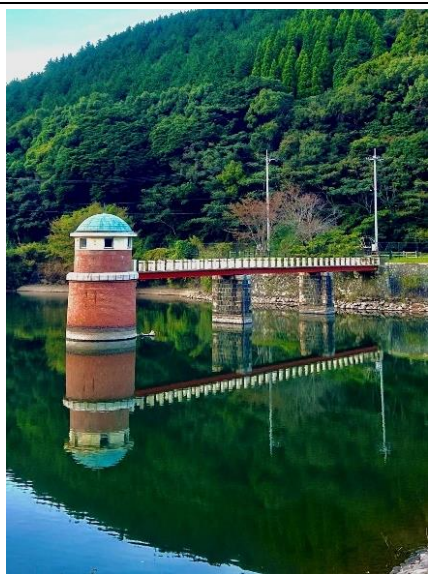
下関市水道局内日第一貯水池取水塔 (下関市)
