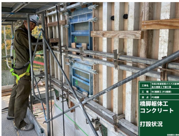
打上高さ確認状況
