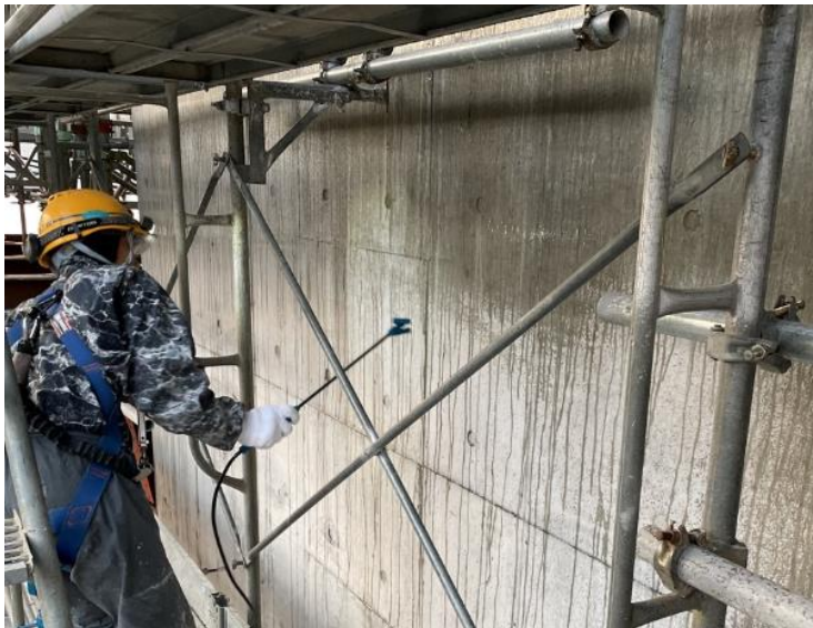
コンクリート改質剤塗布状況
