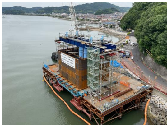
鋼殻ケーソン吊降し前
