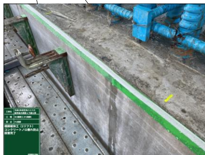
ノロ漏れ防止設置状況
