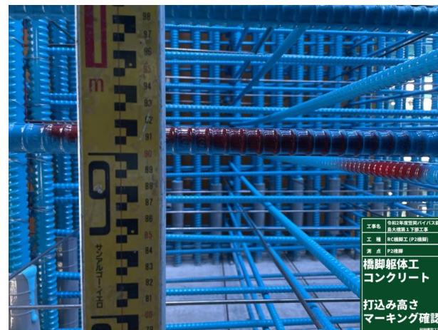
内部打込高さマーキング状況
