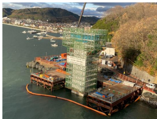
1リフト～4リフト築造
