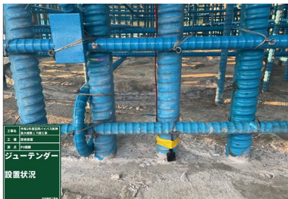
振動デバイス設置状況
