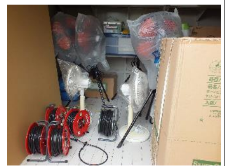
「防災倉庫内の様子」
