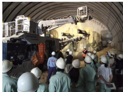
工事現場見学会
