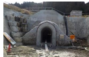
木屋川工水 二条化送水路トンネル工事
