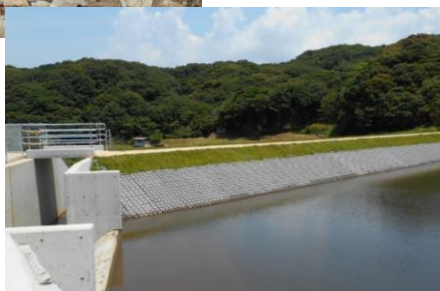
防災重点農業用ため池
