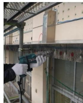
外壁改修工事
