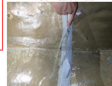
写真3 (塗膜劣化)
