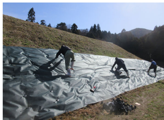
【防草シートの施工】
