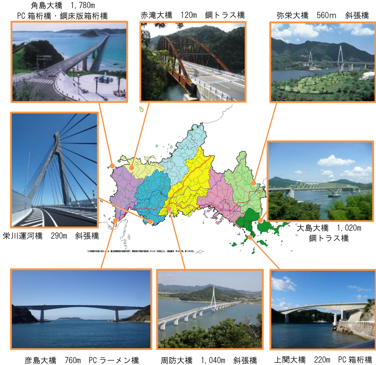
図 2-4 山口県の主な離島架橋・長大橋の位置
