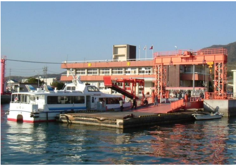
浮棧橋(整備前)
