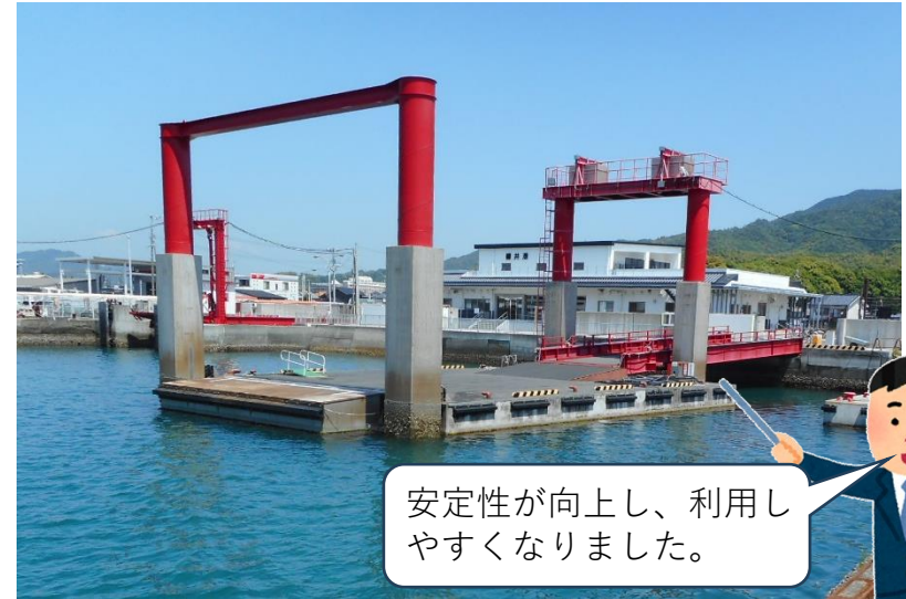
浮棧橋(整備後)
