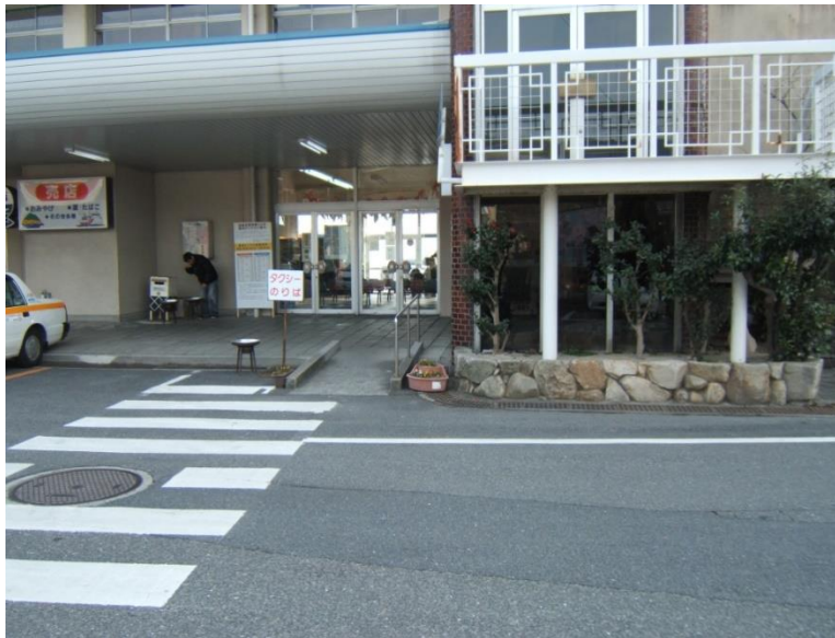
旅客上屋入口付近(整備前)
