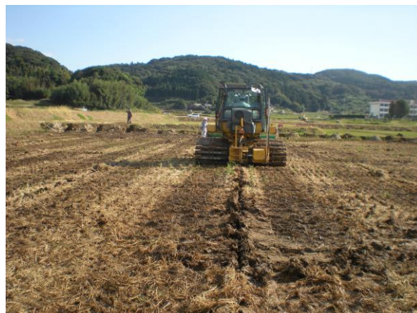
暗渠排水の施工状況 (本郷地区)
