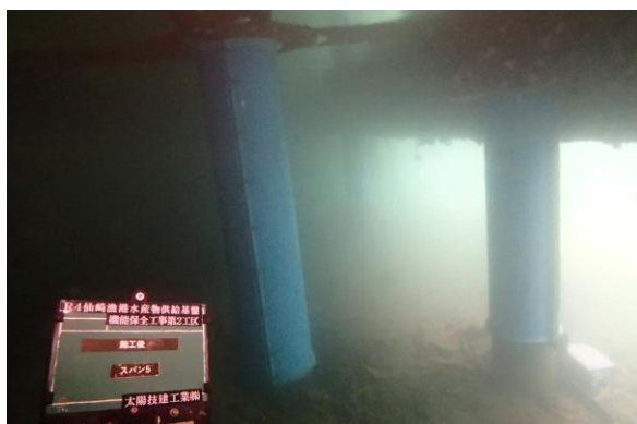
仙崎漁港物揚場基礎補修
