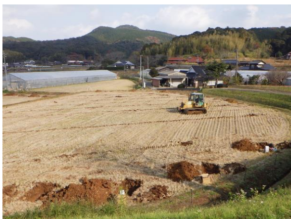
暗渠排水の施工状況 (黄波戸口地区)
