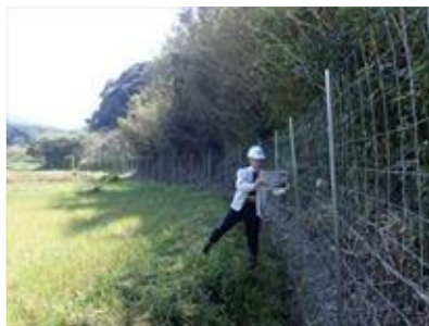
獣害防止柵の設置
