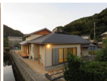
県産木材(長門市産材)を利用した木造住宅
