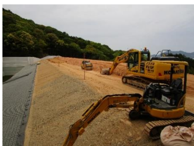
ため池の整備（改修）
