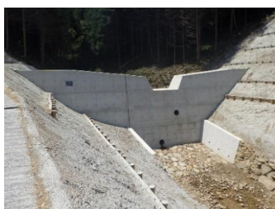
治山ダムの整備
