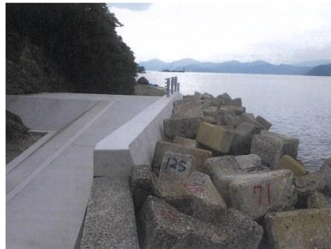
海岸保全施設の整備
