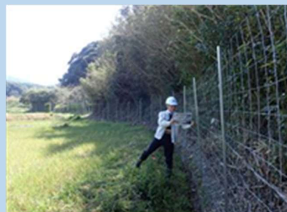
侵入防止柵の設置
