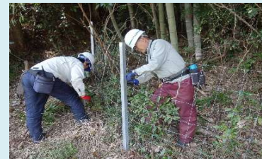
侵入防止柵の補修
