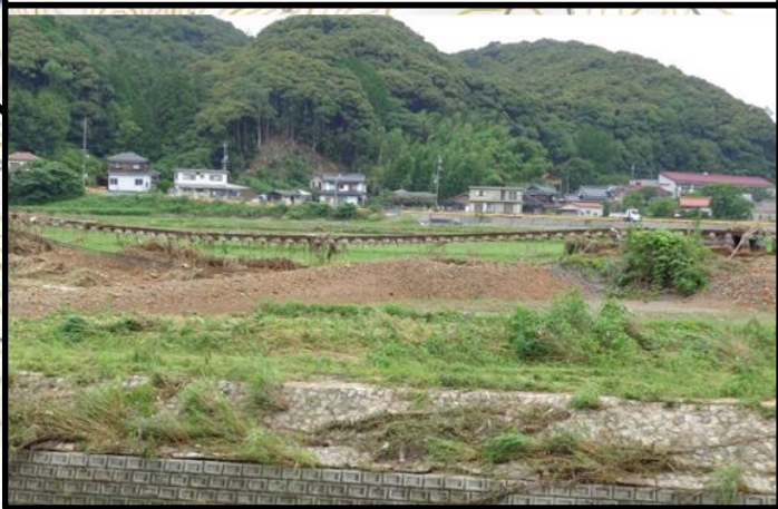
第7厚狭川橋梁付近 (土砂流出)
