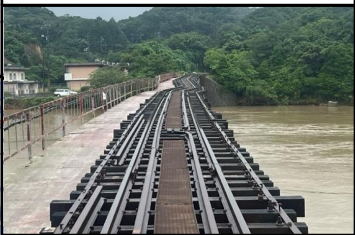
栗野川橋梁 (橋脚傾斜)
