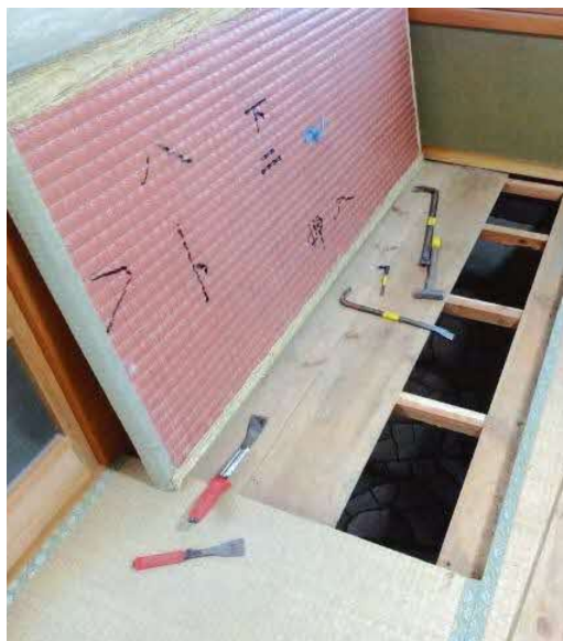
和室の床板をはがす（写真①）
