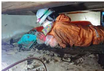
床下の泥だしの様子
