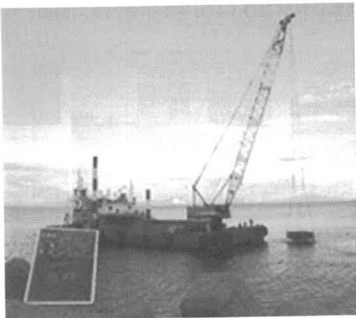
保護礁設置作業
