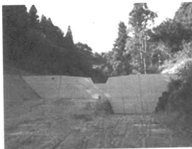
R2 山地災害箇所の復旧状況（施工中）
