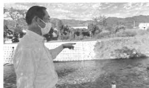
護岸の一部が破損した夜市川を視察
