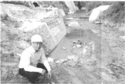
田代川護岸復旧視察
