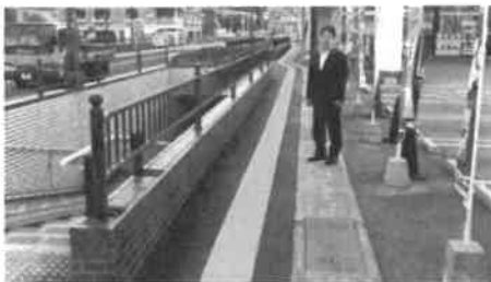
県道204号 宮野地区の舗道整備
