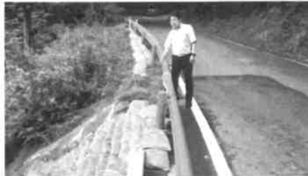
県道26号 仁保石坂の土砂崩れ現場が復旧
