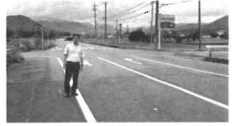
県道26号線 秋川牧園入口、道路区画線を引直し
