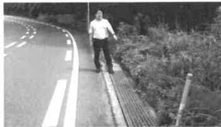
国道376号 徳地町島地 側溝のクレーチング設置で流水防止
