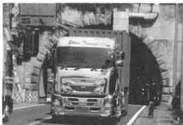
安全性に問題もある長府トンネル付近
