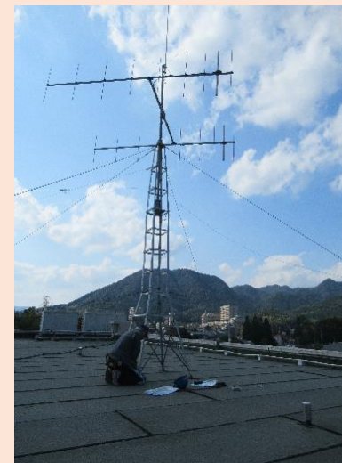
通信設備の整備
