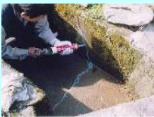
水路のひび割れ補修
