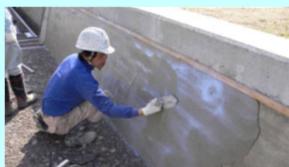
老朽化した水路壁のコーティング
