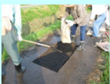
農道の部分補修
