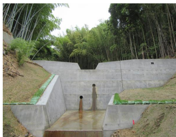
治山ダムの整備
