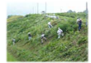
法面の共同草刈り作業
